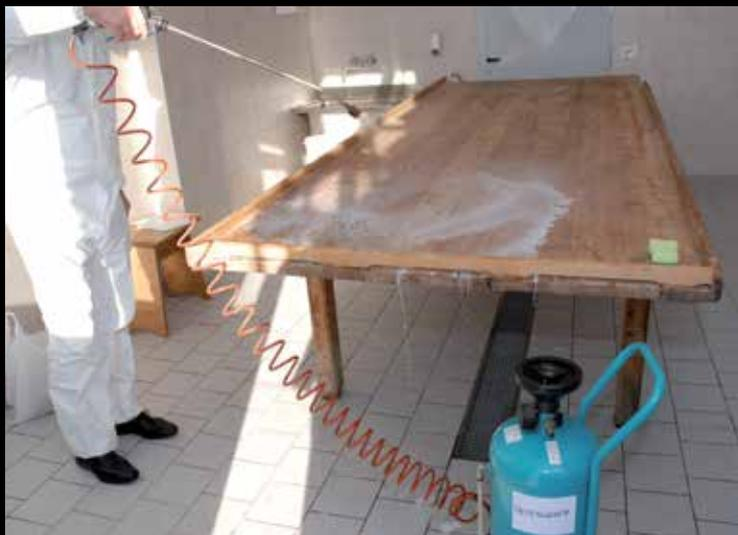
55. Fase di detersione con pompa a bassa pressione
